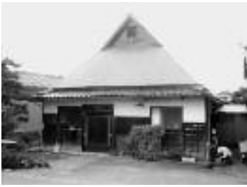
わら 葉ぶき屋根にトタンを被せた民家 (保賀町)
