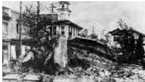
福井震災による被害の様子(大聖寺八間道)
