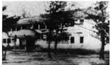
明治 11 年頃の錦城小学校建物
